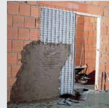
8. Una única capa de enfoscado será suficiente ya que el armazón se suministra preenfoscado.
